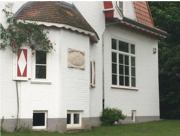
Villa Les Charmettes, façades vers la rue et latérale, détails, photos ERU, 2023.
