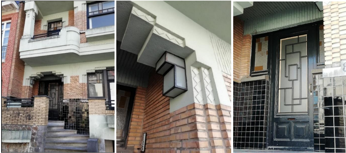
Détails de la façade, photos ERU, 2023.
