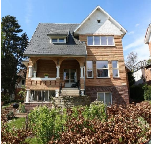
Villa Zonnewende, façade avenue Alfred Madoux, photo ERU.
