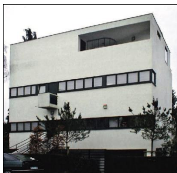
Figure 21 : Rue du Hockey 43, Emile Goffay architecte, 1936 © Histoire et terroir
