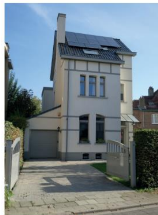
Avenue Paule Isolation de façade et panneaux photovoltaïques
