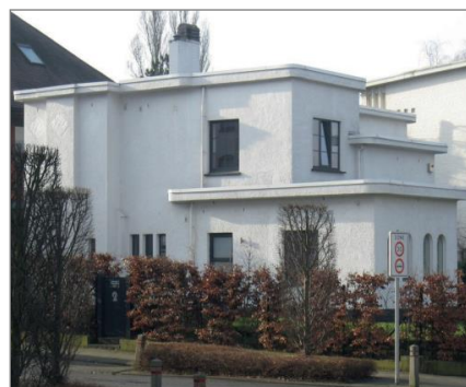
Figure 22 : Rue Mareyde 2, angle avenue E. Parmentier 177. R. Thoelen architecte, Maison pour son beau-père et ses bureaux, 1936
