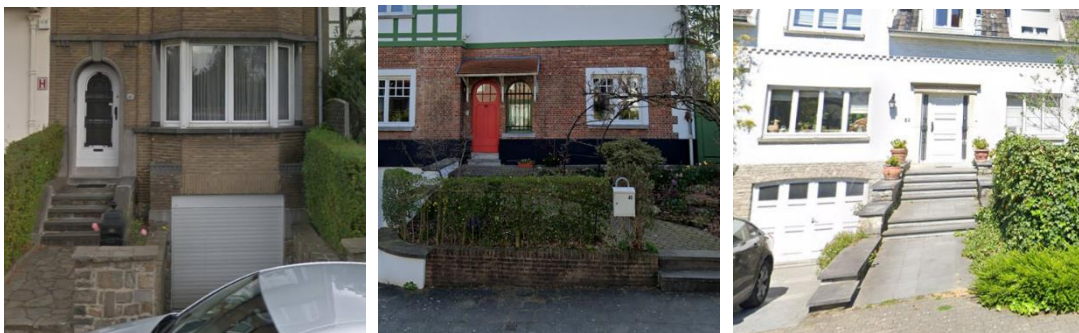
Figure 70 : Difficultés des entrées pour les PMR (source : google street view, consulté en octobre 2022)
