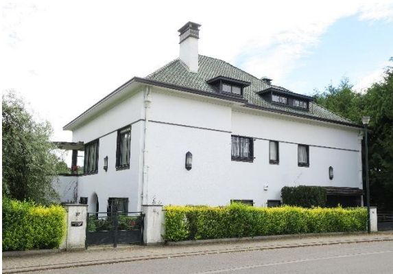
Gezicht op de gevel, foto Urban, 2018.
