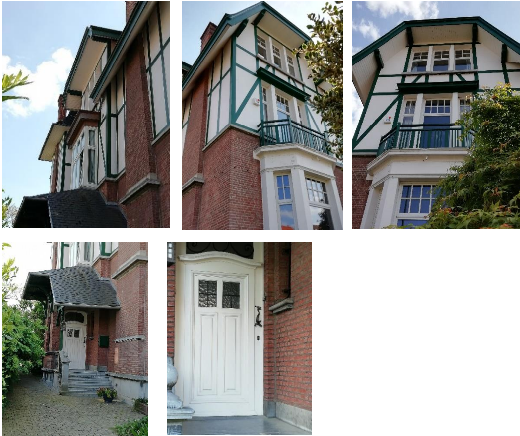
Uitzicht op het Marxhuis en details van de gevel, (ERU-foto's, 2023)
