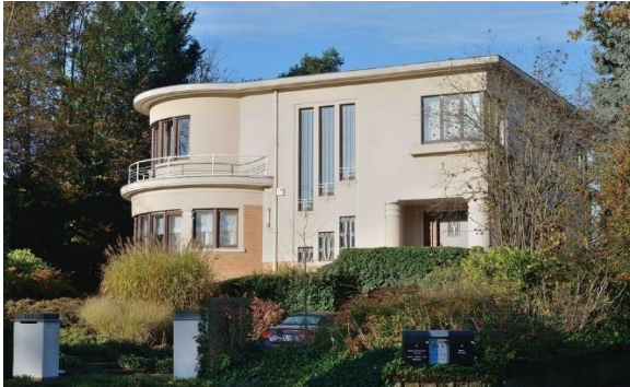
Villa Renwart, foto Inventaris Bouwkundig Erfgoed, 2013.
