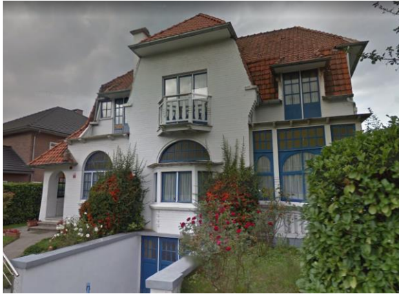
Figuur 9: Voorgevel (bron: Google street view, 2014)
