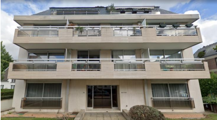
Figuur 11: Voorbeeld van een problematisch gebouw dat voldoet aan de GSV (bron: Google street view)
